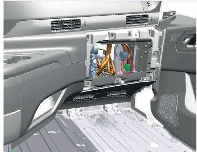
La posizione del connettore upfit situato nella stanza della scatola dei fusibili
